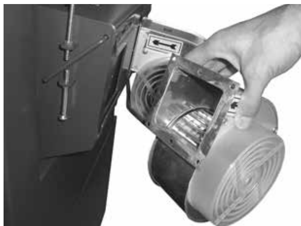
Verificarea ventilatoarelor de împingere aer
